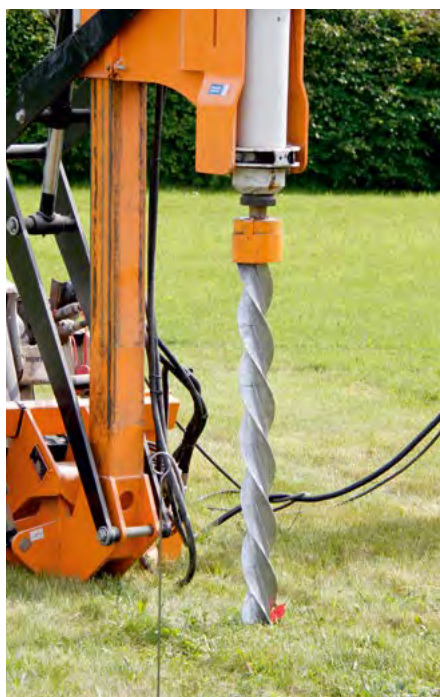
Einrammen der Gewindepfähle Enfoncer les pieux
