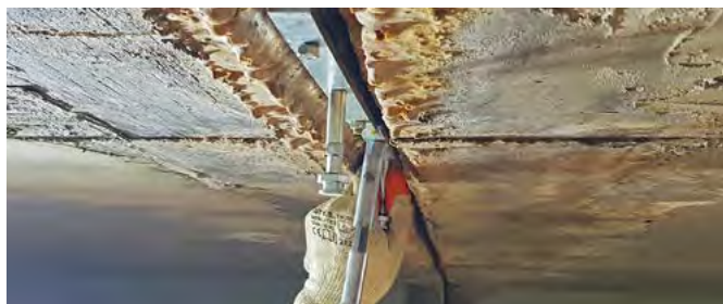
DESOI Quick Seal über das Anzugsrohr spannen | Tendez le joint rapide DESOI sur le tube de traction.
