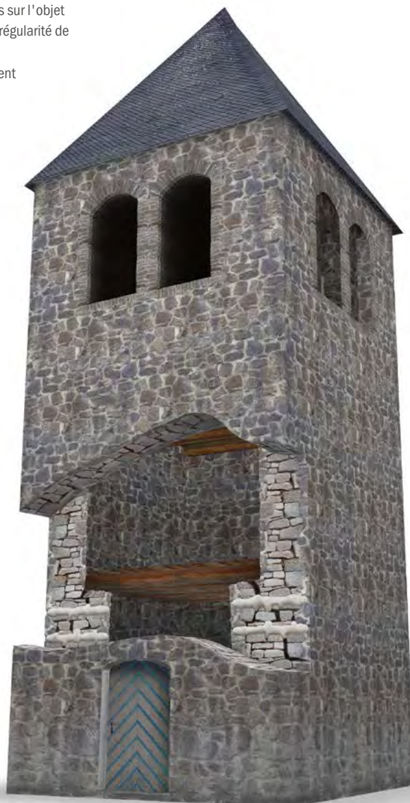
Verbindung abgelöster Mauerwerkschalen Raccordement des murs séparés
