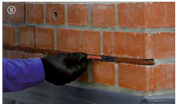
DESOI Spiralankermörtel glattstreichen | Lisser le mortier d'ancrage
