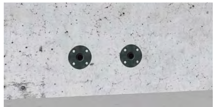
② Nagelpacker nach Entfernen der Schalung ② Injecteurs à clouer après l'enlèvement du coffrage
