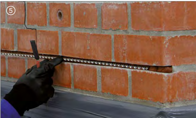
Spiralanker setzen | Placer les tirants hélicoïdaux
