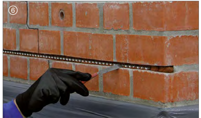
DESOI Spiralanker in den Spiralankermörtel drücken | Encastrier les tirants hélicoïdaux dans le mortier d'ancrage
