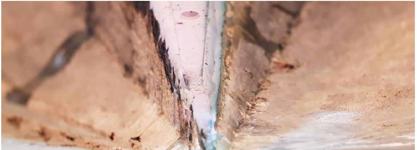
Erfolgreiche Sanierung der Fuge mit dem DESOI Quick Seal und dem Rechteck-Stahlpacker | Réparation réussie du joint avec le DESOI Quick Seal et l'injecteur en acier rectangulaire
