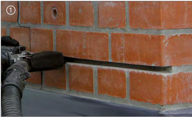
Fuge mit AS200X Stein- und Fugensäge aussägen Scier le joint avec la Scie à brique et mortier AS200X
