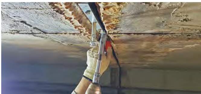
Einbau und Befestigung des DESOI Quick Seal Installation et fixation du DESOI Quick Seal
