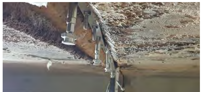
Eingebautes DESOI Quick Seal in einer Fuge | DESOI Quick Seal intégré dans un joint
