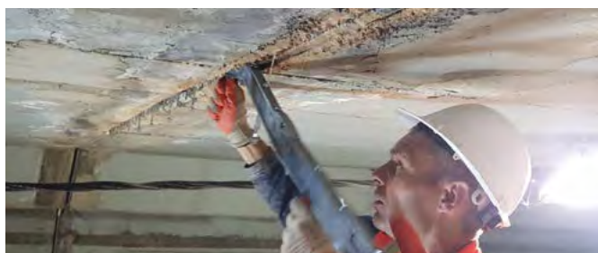
Nach Aushärten des Füllstoffes DESOI Quick Seal einfach entfernen Après le durcissement du mastic, il suffit d'enlever le joint rapide DESOI.
