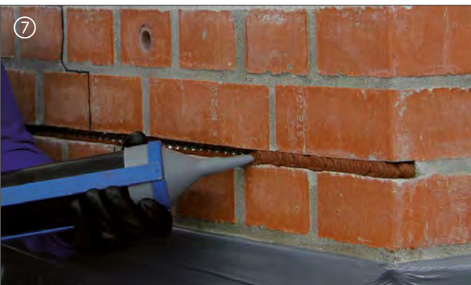
Zweite Lage DESOI Spiralankermörtel einbringen Remplir le joint d'une couche de mortier d'ancrage
