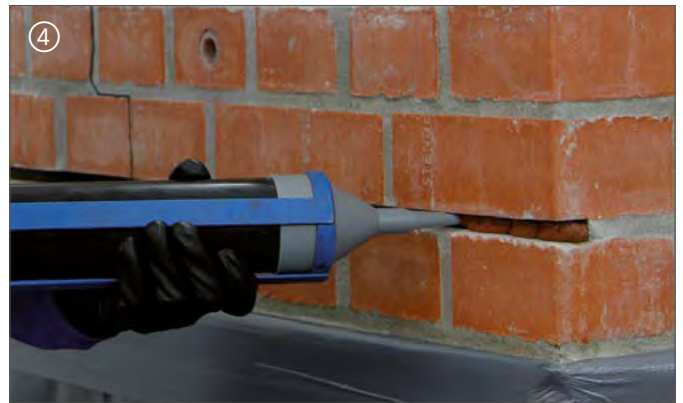
Erste Lage DESOI Spiralankermörtel einbringen | Remplir le joint d'une couche de mortier d'ancrage
