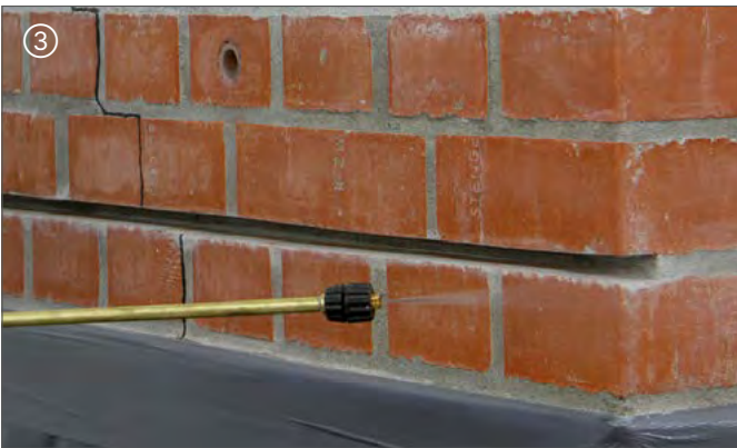
Fuge vornässen | Mouiller le joint
