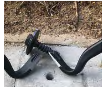
Ziehvorrichtung ansetzen und Packer herausziehen | Placer le dispositif de tirage et sortir l'injecteur
