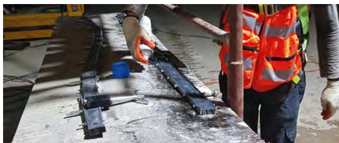
Auftragen des Schutzfilms mit Silikon-Spray Application du film de protection avec un spray de silicone
