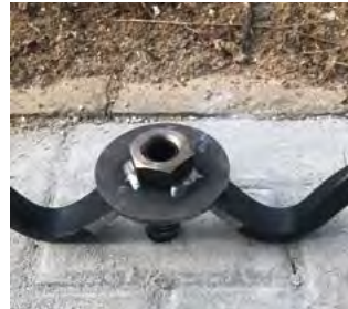
Flanschmutter aufschrauben Visser l'écrou à bride
